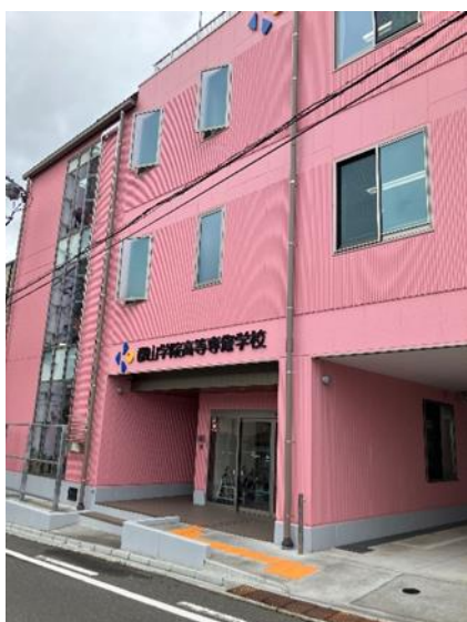
図5 郡山学院高等専修学校校舎①
